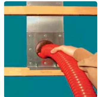
Einführen des Einblas Schlauchs
