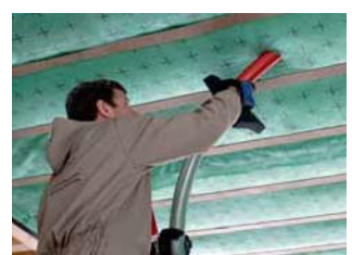
Einbläser mit Einblasnadel an der Decke
