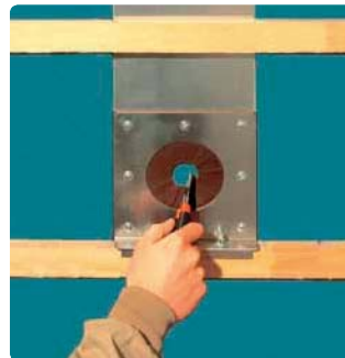
Herstellen der Einblasöffnung
