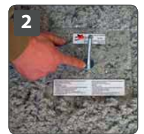
2 Dickenmessung einer offen aufgeblasenen Dämmung mit dem Dickenmesser
