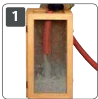
1 Verdichtetes Einblasen mit Schlauch
