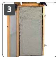
3 Öffnen des Prüfelement und begutachten des Befüllergebnisses
