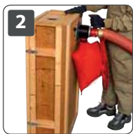
2 Verdichtetes Einblasen mit entlüfteter Drehdüse
