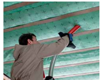
Einbläser mit Einblasnadel an der Decke
