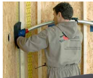
Einblasnadel in der Anwendung mit Abdichtschwamm
