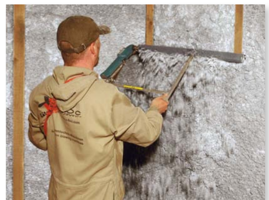
Planbürsten einer zuvor aufgesprühnten Wärmedämmung
