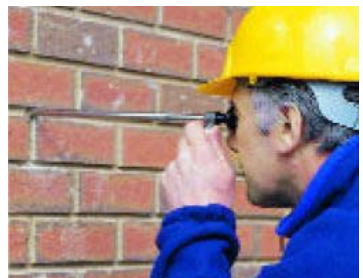
Inspektion einer Hohlschichtwand
