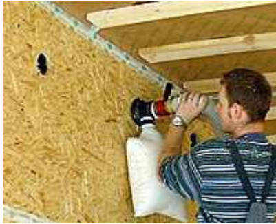
Bild: Befüllung mit der Drehdüse
