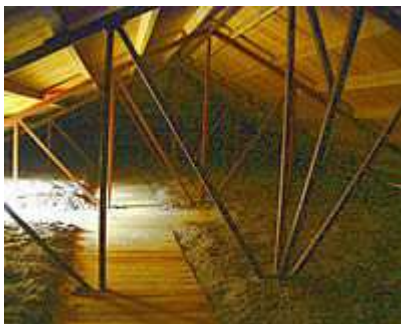
Bild: Deckendämmung aufgeblasen
